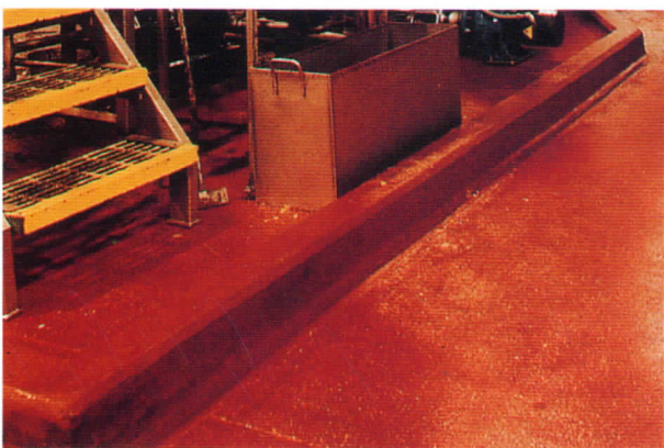
德固 UCRETE WR，英國，食品廠止水墩
