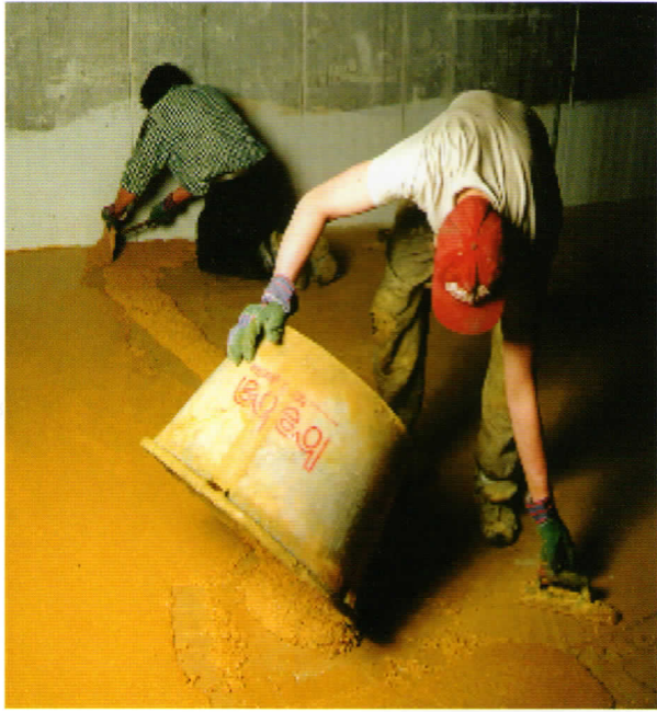
德國UCRETE 現場施工
